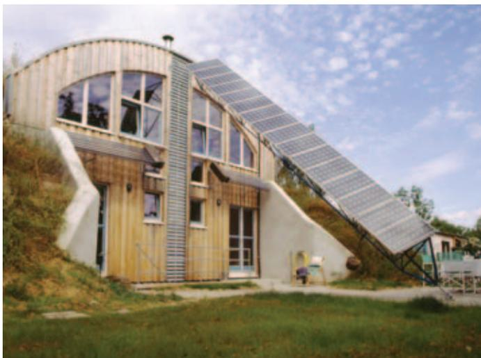
**Bild 3** Seit 14 Jahren vom Architekten bewohntes Erdhügelhaus. Am Südgiebel angebrachte Solarkollektoren erzeugen nicht nur etwa 60 % des jährlichen Energiebedarfs für Warmwasser, sondern sie dienen gleichzeitig als Regenschutz und sommerlicher Schattenspender für die Terrassentüren.
