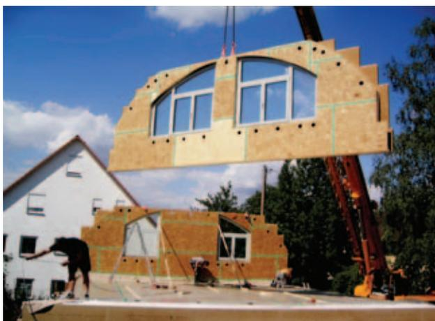
Bild 9 Aus je zwei vorgefertigten Holzrahmenelementen werden die Giebelwände zusammengesetzt.
