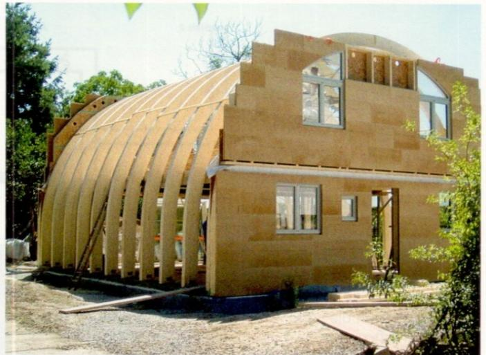
Das Skelett des Gebäudes besteht aus selbsttragenden Leimbindern und Giebeln in Holzrahmenbau.
